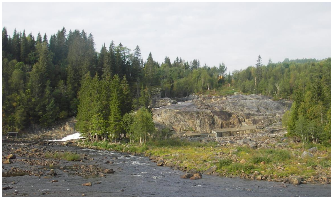
Figur 7. Bildet viser Berrefossen. Inntaket til trappa ligger bak skogen til høyre for selve fossen. Foto: Anton Rikstad.
