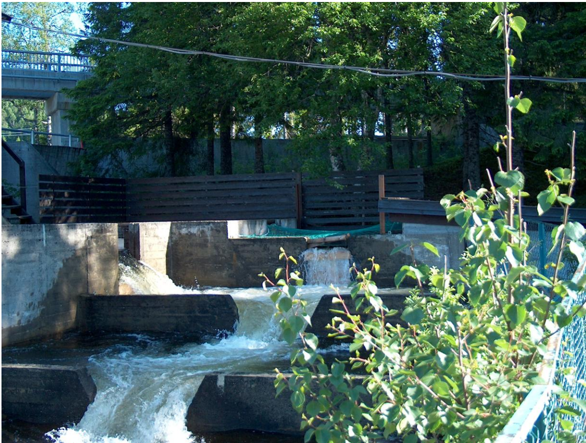
Figur 3. Bildet viser fisketrappa i Fiskumfoss, som er en konvensjonell kulpetrapp hvor fisken kan svømme fra kulp til kulp.
